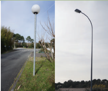
Rénovation éclairage public Changement des lampes à mercure (à gauche) et remplacement des éclairages fortes puissances par des LEDS (à droite).
